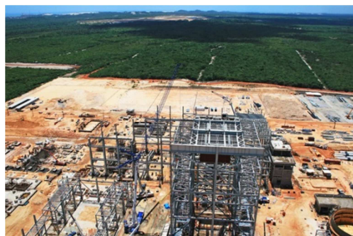
Figura 2: Vista Geral da obra UTE Fonte: Elaborado pelo autor
