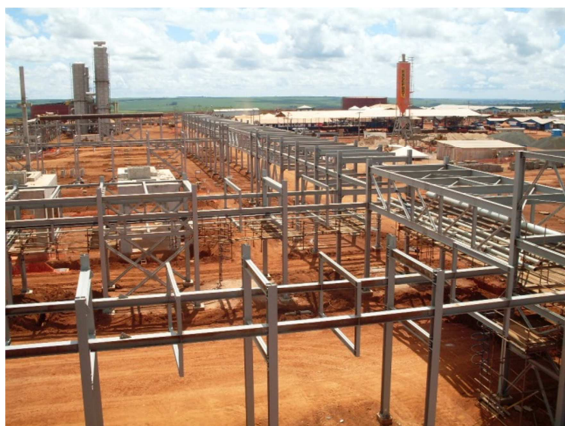
Figura 13: Obra COSAN Fonte: Elaborado pelo autor
