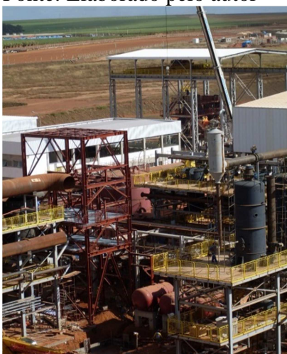
Figura 17: Obra COSAN Fonte: Elaborado pelo autor
