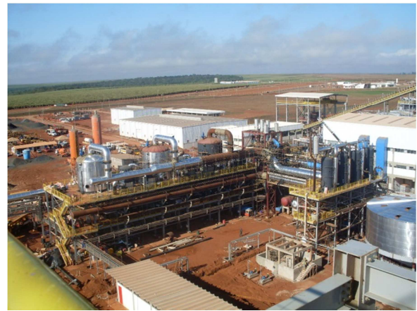
Figura 24: Obra COSAN Fonte: Elaborado pelo autor
