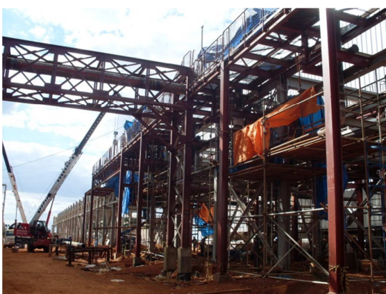
Figura 19: Obra COSAN Fonte: Elaborado pelo autor
