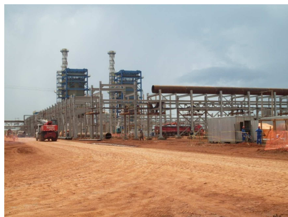
Figura 16: Obra COSAN Fonte: Elaborado pelo autor
