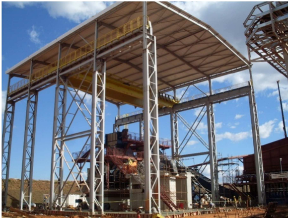
Figura 21: Obra COSAN Fonte: Elaborado pelo autor
