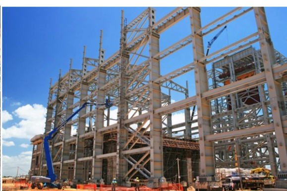
Figura 4: Obra Turbina 1 Fonte: Elaborado pelo autor
