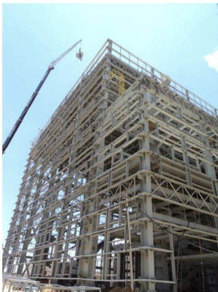
Figura 9: Obra Turbina 1 Fonte: Elaborado pelo autor
