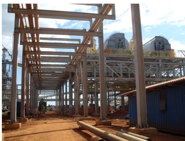
Figura 18: Obra COSAN Fonte: Elaborado pelo autor
