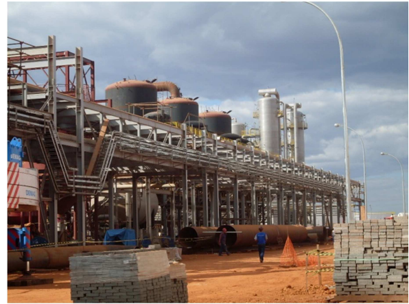
Figura 22: Obra COSAN Fonte: Elaborado pelo autor
