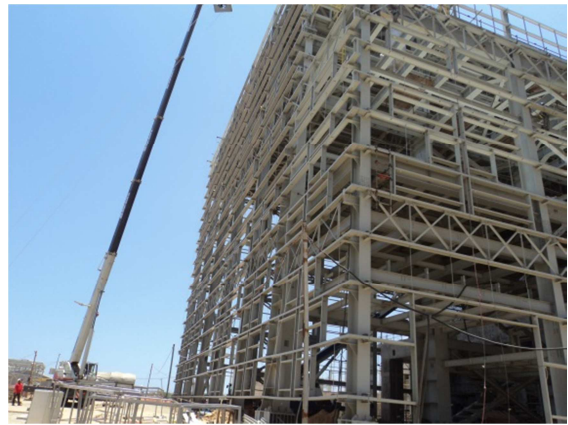
Figura 8: Obra Turbina 1 Fonte: Elaborado pelo autor
