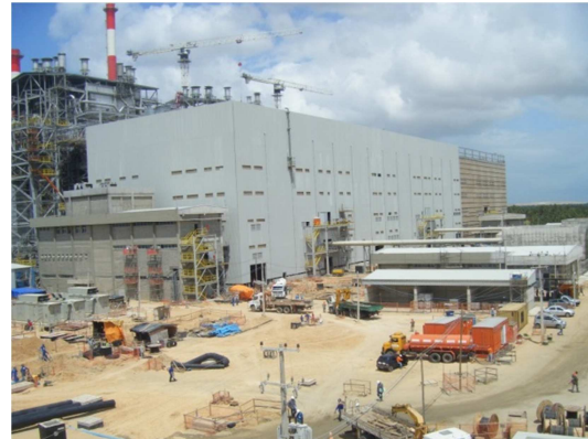
Figura 12: Obra Turbina 1 Fonte: Elaborado pelo autor
