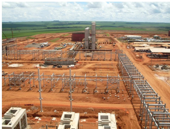
Figura 14: Obra COSAN Fonte: Elaborado pelo autor
