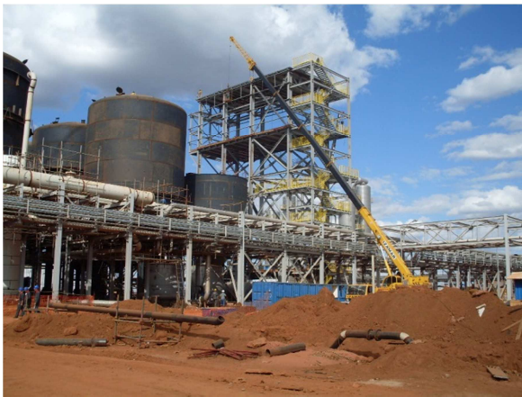
Figura 23: Obra COSAN Fonte: Elaborado pelo autor
