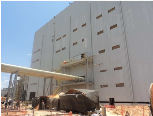
Figura 11: Obra Turbina 1 Fonte: Elaborado pelo autor
