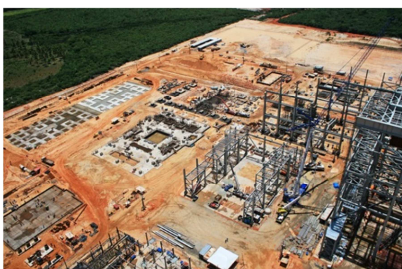
Figura 3: Vista geral da obra da UTE Fonte: Elaborado pelo autor
