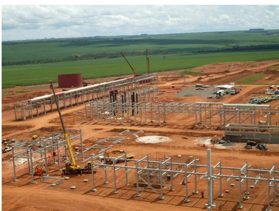
Figura 15: Obra COSAN Fonte: Elaborado pelo autor
