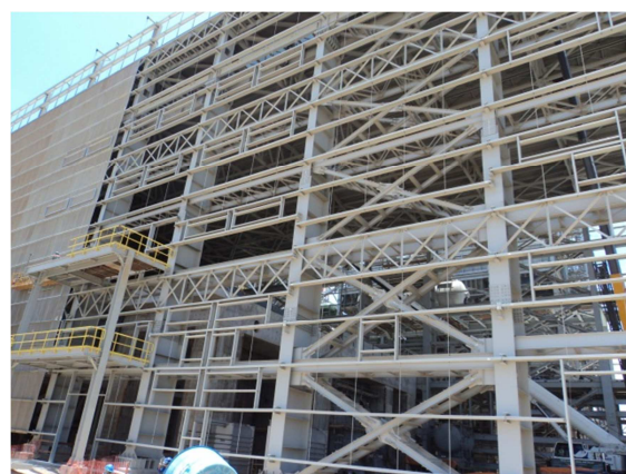
Figura 10: Obra Turbina 1 Fonte: Elaborado pelo autor
