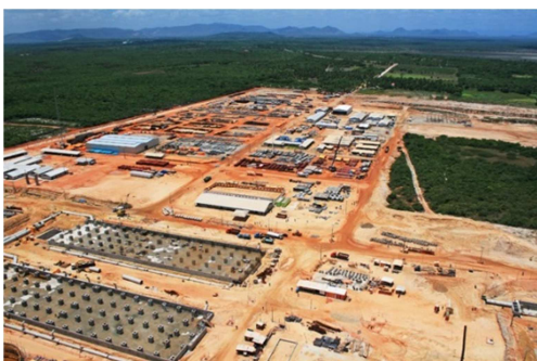
Figura 1: Vista geral da obra UTE Fonte: Elaborado pelo autor
