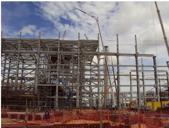
Figura 7: Obra Turbina 1 Fonte: Elaborado pelo autor
