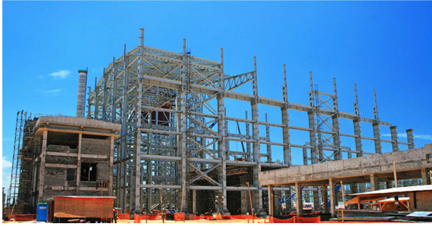
Figura 5: Obra Turbina 1 Fonte: Elaborado pelo autor
