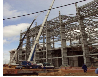
Figura 6: Obra Turbina 1 Fonte: Elaborado pelo autor
