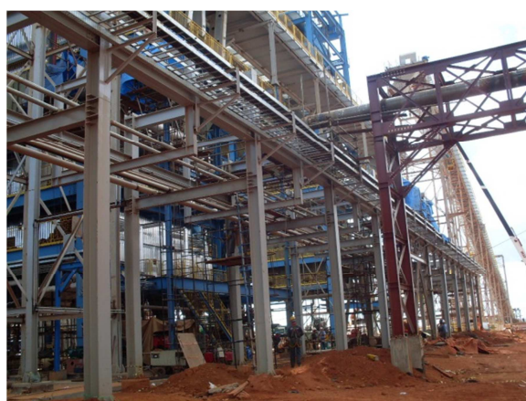
Figura 20: Obra COSAN Fonte: Elaborado pelo autor
